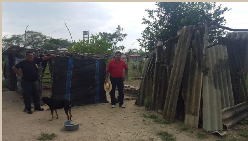
Letrinas del Puesto de Vigilancia
