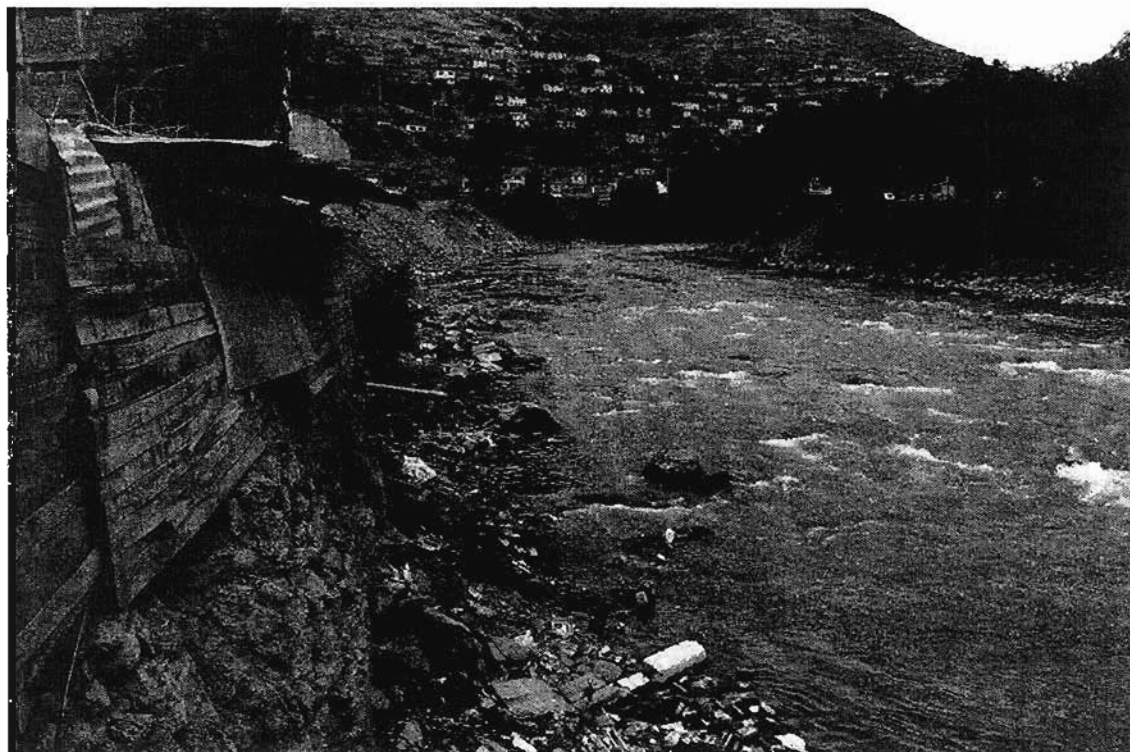
Basura visible a las orillas del Río Huallaga.
