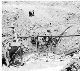
Preocupa estado de la obra. Augusto Valero
