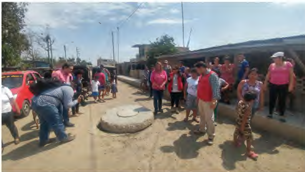
Verificando las obras de agua y alcantarillado del distrito de Pucala
