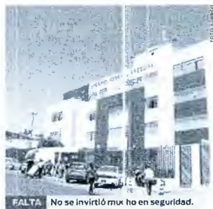
FALTA. No se invirtió mucho en seguridad.
