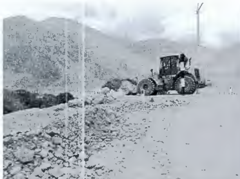
Reforzando la defensas riverañas con maquinaria pesada
