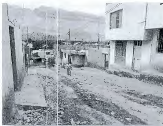
La emergencia estuvo en Aplao, en la provincia de Castilla, donde decenas de viviendas fueron afectadas con la desgracia de tres personas fallecidas a causa de los huaicos.
