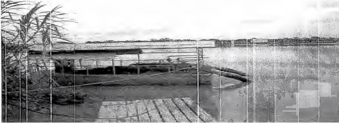
Foto: Captación superficial, mediante sistema de balsa cautiva ubicada a orillas del río Madre de Dios
