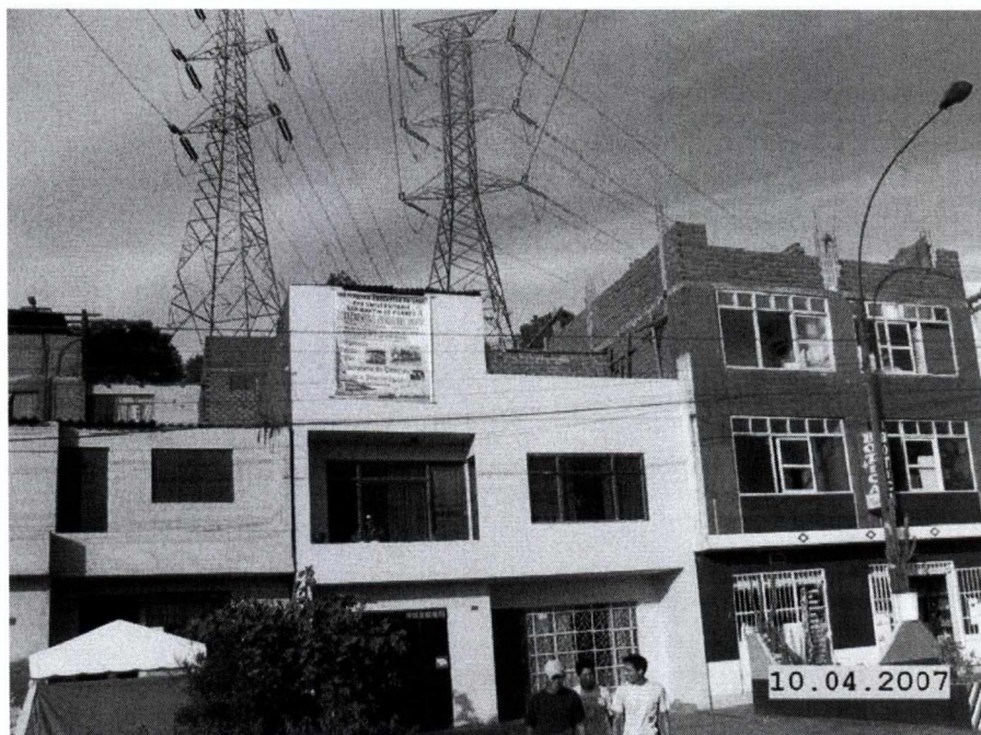
Foto: Construcciones de material noble por debajo de cables de alta tensión.
