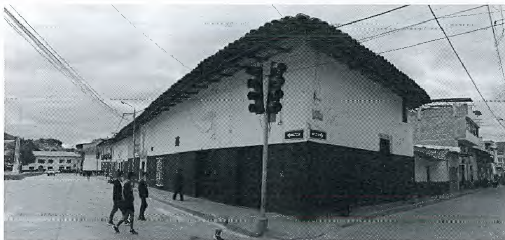
Foto N° 21: Vista desde el exterior de la Casa donde vivió José Faustino Sánchez Carrión.
