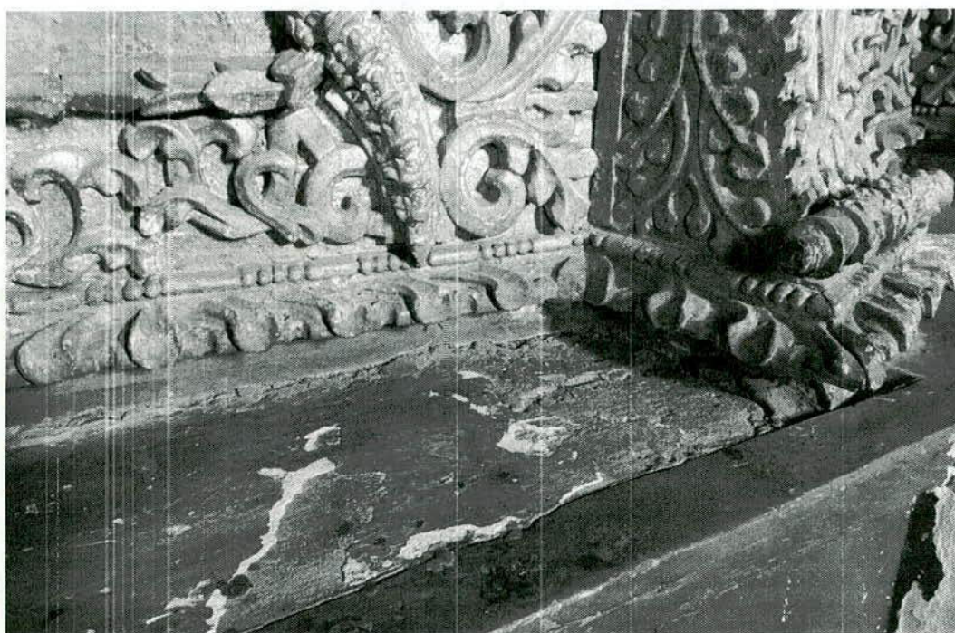
Estado de conservación general de la iglesia matriz
