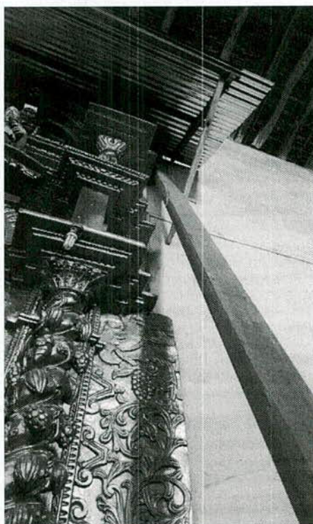
Vigas de madera vienen soportando la estructura de la iglesia matriz
