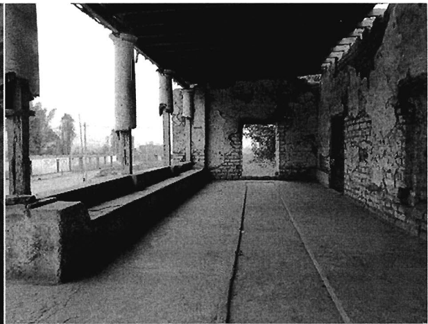
Corredor de Casa Hacienda
